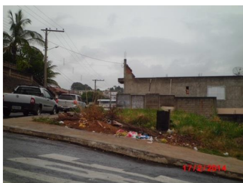
Figura 35: Presença de resíduos alocados nas ruas e nas margens dos rios no perímetro urbano. Fonte: Conen
