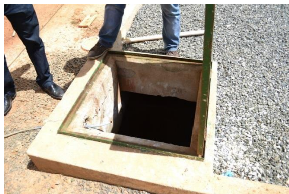
Figura 19: Lançamento de cloro Fonte: Conen
