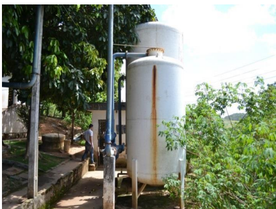
Figura 20: Antiga ETA – atualmente utilizada como reservação Fonte: Conen
