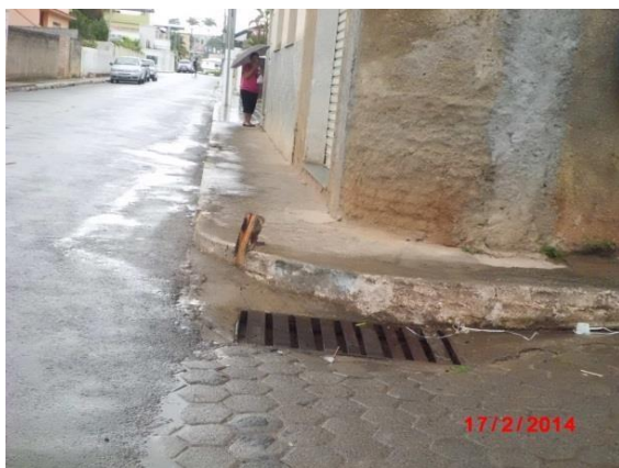
Figura 32: Estruturas de drenagem presenciadas em algumas ruas da cidade. Fonte: Conen
