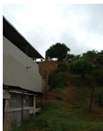
Figura 25: Reservatório Esplanada Fonte: Conen
