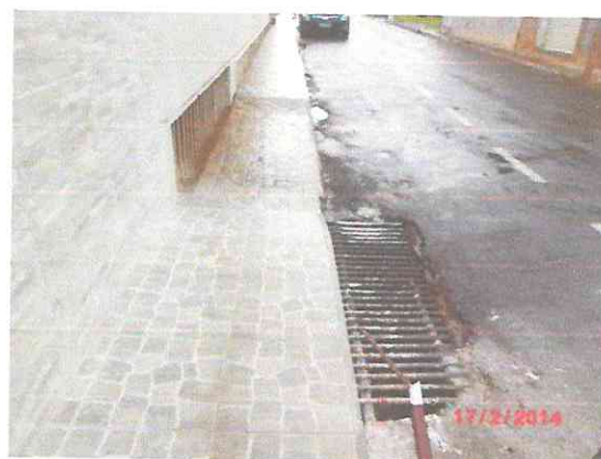
Figura 33: Estruturas de drenagem presenciadas em algumas ruas da cidade. Fonte: Conen
